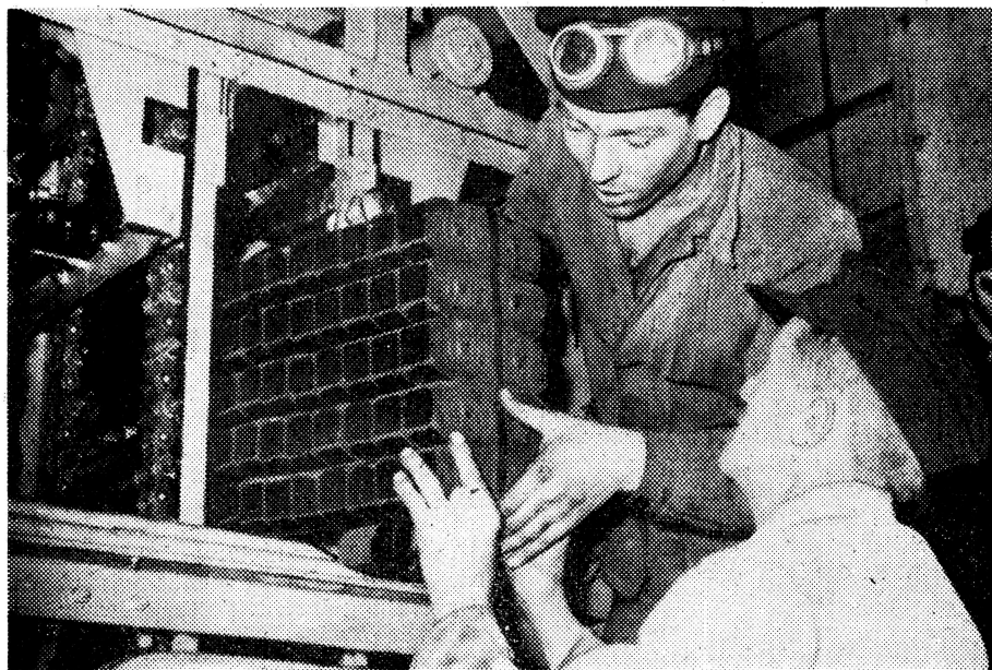
Maschinenschlosser Meister Heinz Göllnitz (rechts) und Kollege Kurt Fallenbeck gehören zu dem Kollektiv, das die teilautomatische Brikettbündelmaschine im Braunkohlenwerk Rositz konstruierte und das erste Funktionsmuster baute
