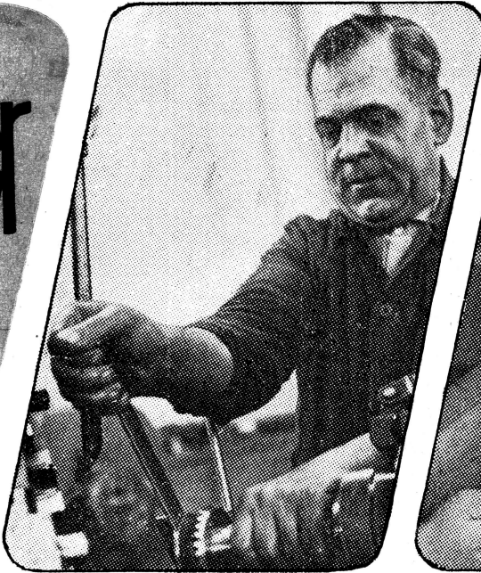
Genosse Kurt Ehrig, VEB Großdrehmaschinenbau „7. Oktober“, Berlin-Weißensee: „Durch verbessertes, rationelleres Einrichten der Kegelradhobelmachine ist es mir gelungen, die Fertigungszeit bei gleichbleibendem Lohn um 35 Prozent zu senken.“
