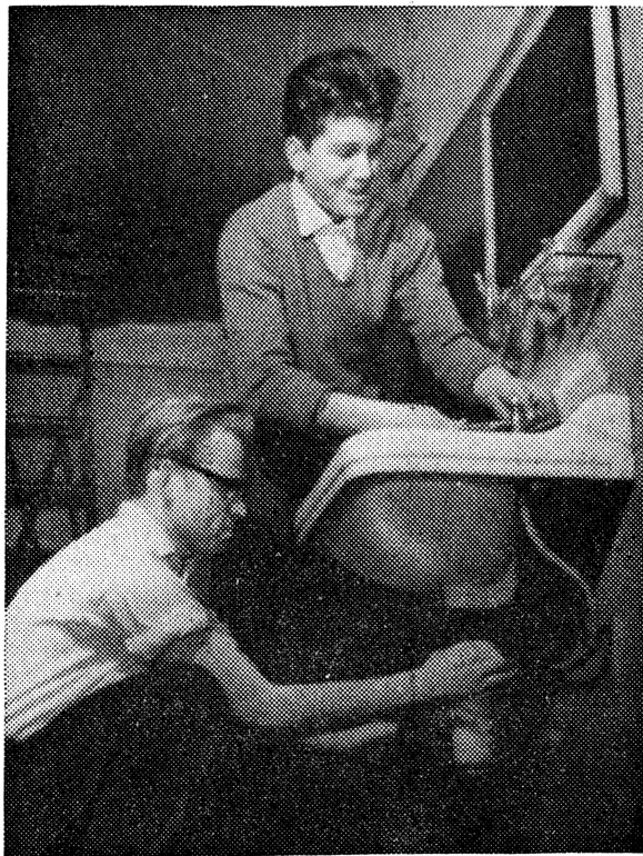
Im Leipziger Stadtbezirk Mitte wurde ein Reparaturstützpunkt der Nationalen Front geschaffen, für den sich 14 Handwerker aus dem Wohngebiet zur Verfügung stellten. Unser Foto: Klempner Peter Hoffmann und Lehrling Klaus Quietsch reparieren nach Feierabend eine Wascheinrichtung
