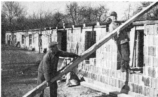
Genossenschaftsbauern beim Bau eines Entenstalles mit Futterraum und Brutanlage für die genossenschaftliche Geflügelhaltung der LPG „Frisch auf“ in Görbitzhausen
