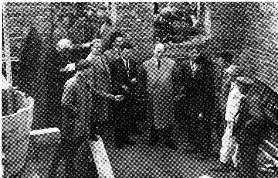
Am 8. September besuchte Genosse Walter Ulbricht die Genossenschaftsbauern der Gemeinde Zickhusen bei Schwerin. Hier bei der Besichtigung eines Stallneubaus
