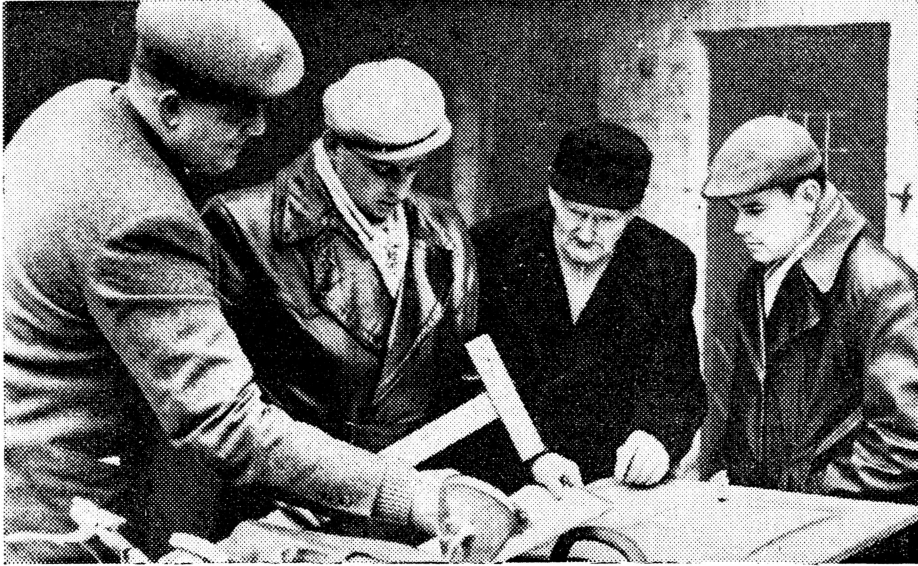
Gemeinsam berieten Vertreter der Feldberger Bürger und der Bauleitung über die Errichtung des Kulturraumes
