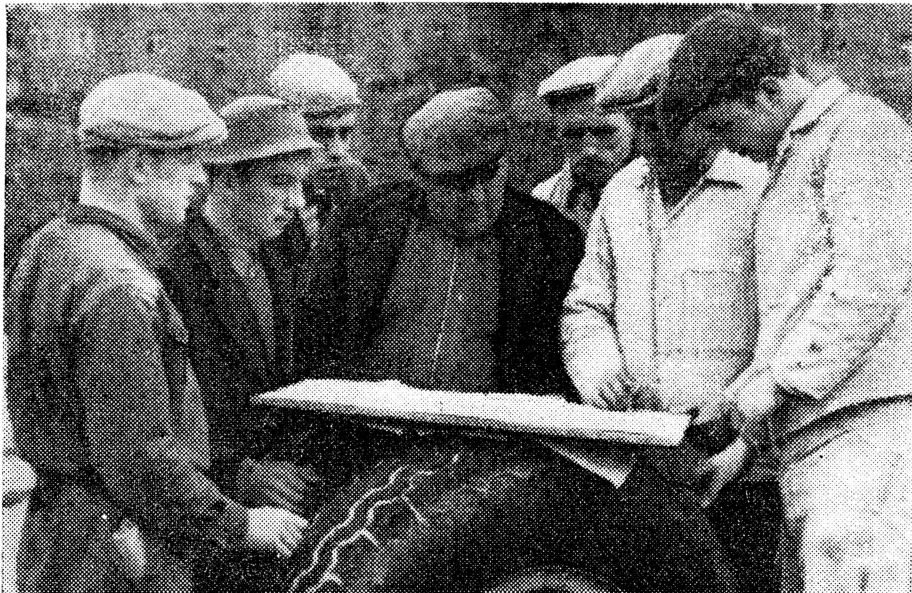
Genosse Max Oeser (Mitte) und Mitglieder der Jugendbrigade bei einer Besprechung auf der Baustelle in Berlin-Treptow
