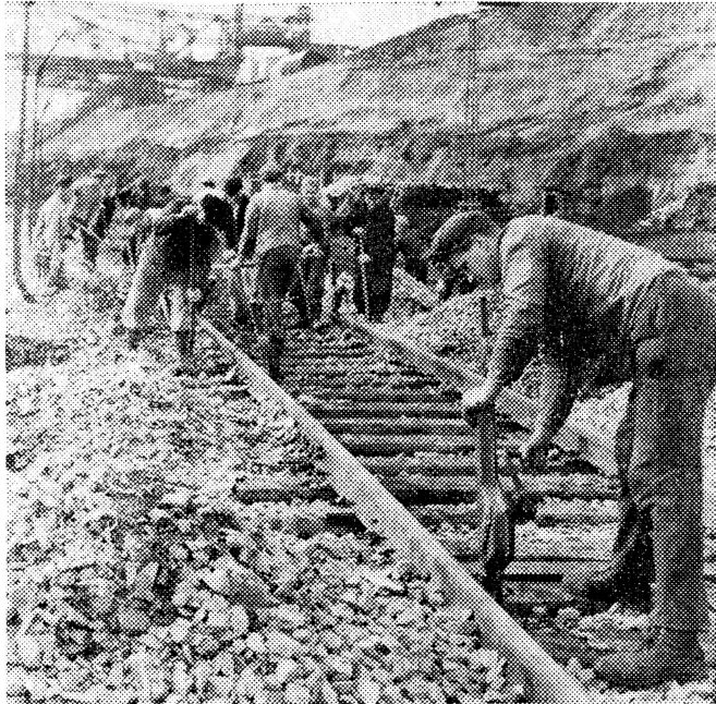
Umbau der Gleisstrecke im BKW Spreetal auf Normalspur. Nach der vollständigen Umspurung können pro Tag 7000 Tonnen Kohle für das Kombinat „Schwarze Pumpe“ mehr geliefert werden.
