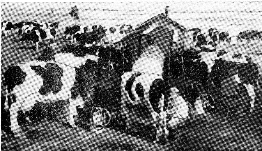
*Unter Leitung des Technikers im MTS-Stützpunkt, Willi Drews, bauten sich die Genossenschaftsbauern der LPG „Zukunft“ in Mesekenhagen auf einem zweirädrigen Karren, einem alten Dieselmotor und ein paar Rohren einen fahrbaren Weidemelkstand für zehn Kühe*
