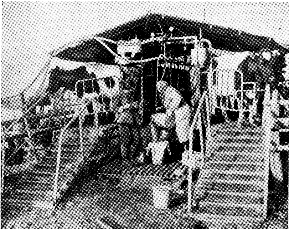
Fahrbarer Fischgrätenmelkstand der LPG Kremmen, Kreis Oranienburg. Eine Milchleistung sprüfer in kontrolliert die Leistung je Kuh
