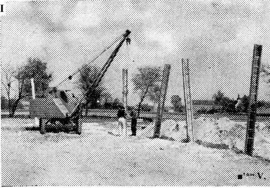
*Einsetzen der Normalmasten aus Stahlsaitenbeton mit dem Dungalader. Hier ist eine ausgezeichnete Verbindung der Mechanik der Landwirtschaft mit den Bedürfnissen der Bauindustrie gelungen*
