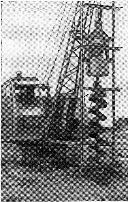
*Mechanischer Erdbohrer; durch den eine Steigerung der Arbeitsproduktivität gegenüber der traditionellen Bauweise um das Fünffache erzielt wird.*
