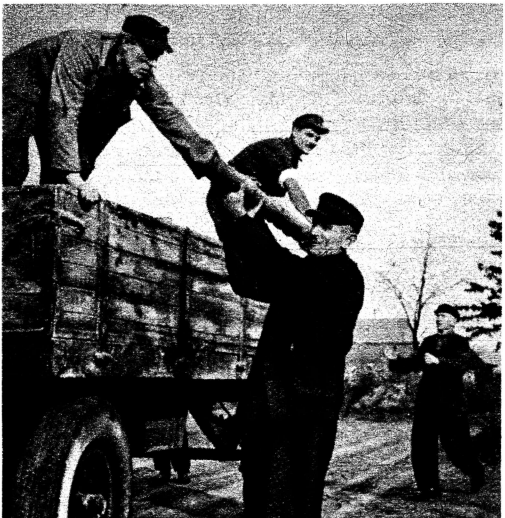
Schon in wenigen Tagen werden die zum Bau notwendigen Stangen, Schalbretter und Nägel durch die VdgB (BHG) angeliefert. Zum Eindecken der Hütte wird Holz aus der Hilfe verwendet.
