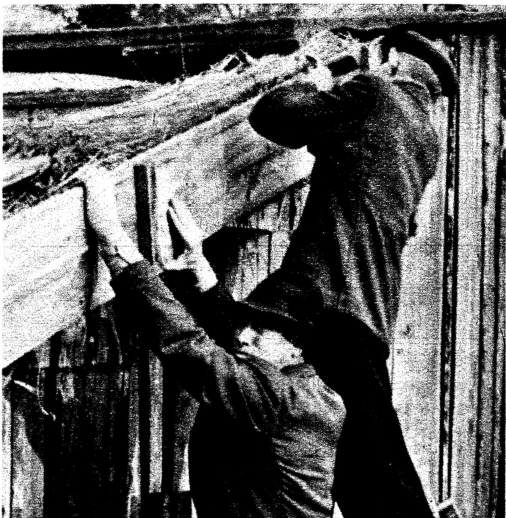
Die Gemeinschaftshilfe der Neubauern, angeregt durch die Parteiorganisation, erleichtert die Arbeit für jeden Beteiligten und führt dazu, daß der Kreis der Baulustigen ständig wächst.
