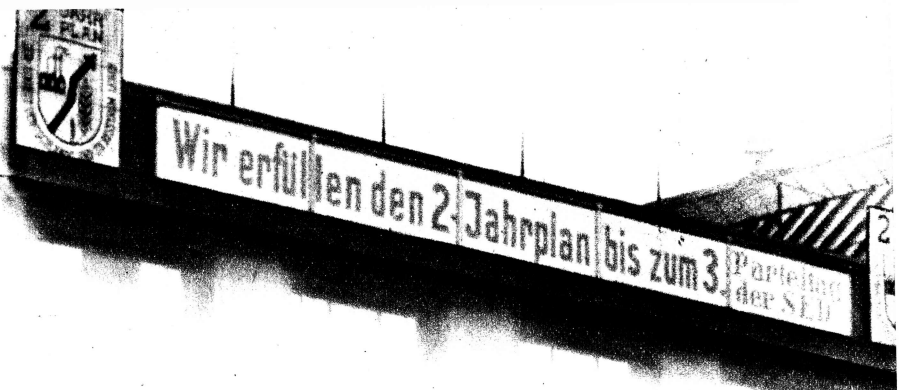
Transparente an den Fassaden der Betriebe verraten dem Außenstehenden hier hat die Belegschaft den Aufruf der SED aufgenommen. Auf unserem Bilde das VEB Transformatoren- und Röntgenwerk Dresden. (Aufn. Krisch)
