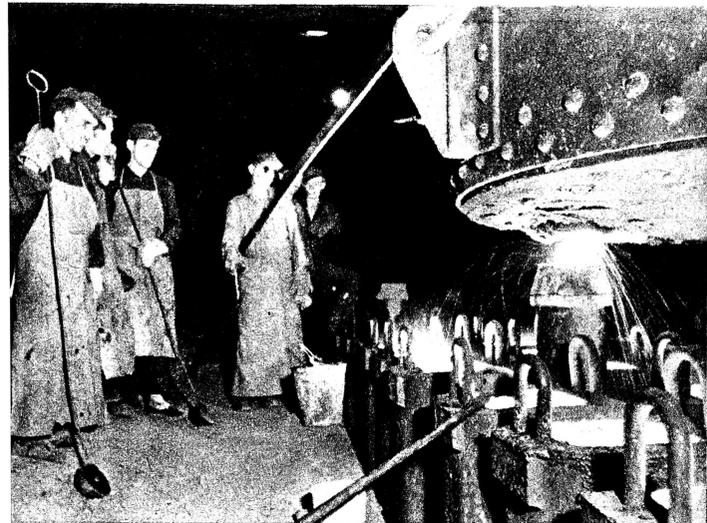
Ist der Zeitpunkt des Ausstoßes gekommen, heißt es für den Hüttenwerker aufpassen. Ein gleichmäßig ruhiger Guß in die bereitstehenden Kokillen in der Gießgrube garantiert einen guten Stahl. Die Oberflächen der vollen Kokillen werden mit Wasser abgelöscht (Bild unten). Auch diese Maßnahme soll zur Qualitätsverbesserung beitragen. (Aufn. Hensky)
