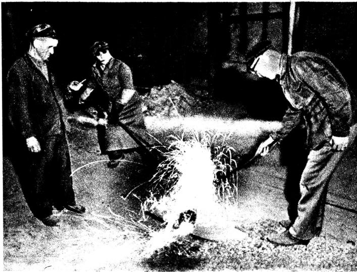
Vor dem Ausstoß aus dem Martinofen wird mehrere Male eine Gußprobe entnommen und dem Labor zur Herstellung der technischen Analyse übergeben. Entstehen bei der Beschickung des Ofens durch Fahrlässigkeit Fehler, so rächen sich diese schwer bei dem weiteren Produktionsverlauf in anderen Abteilungen, die dann vergeblich um ihre Ausschußsenkung kämpfen.
