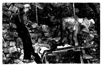
Im Ringofen wird der Kalkstein gebrannt. Die Steine werden vom Ringofensetzer so gesetzt, daß genügend Luftzüge'für den Brennprozeß vorhanden sind. Die Arbeitsnorm liegt allerdings mit 15 cbm pro Mann und Schicht noch erheblich unter der Vorkriegsnorm, die 20 cbm betrug. Das hat zu einem wesentlichen Teil seine Ursache in noch nicht beseitigten technischen Mängeln.
