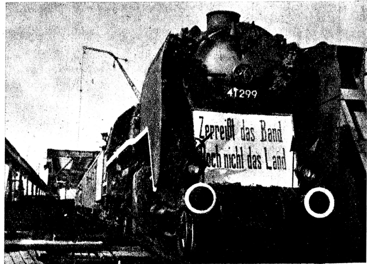
Stetig schreitet der wirtschaftliche Aufbau in der Ostzone legene große EisenbahnbrückeHämerteH nach umfangreichen
