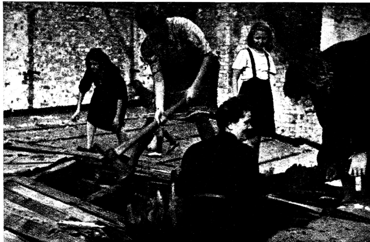
Denkt an den Winter! Repariert die Dächer und macht die Wohnungen winterfest!
