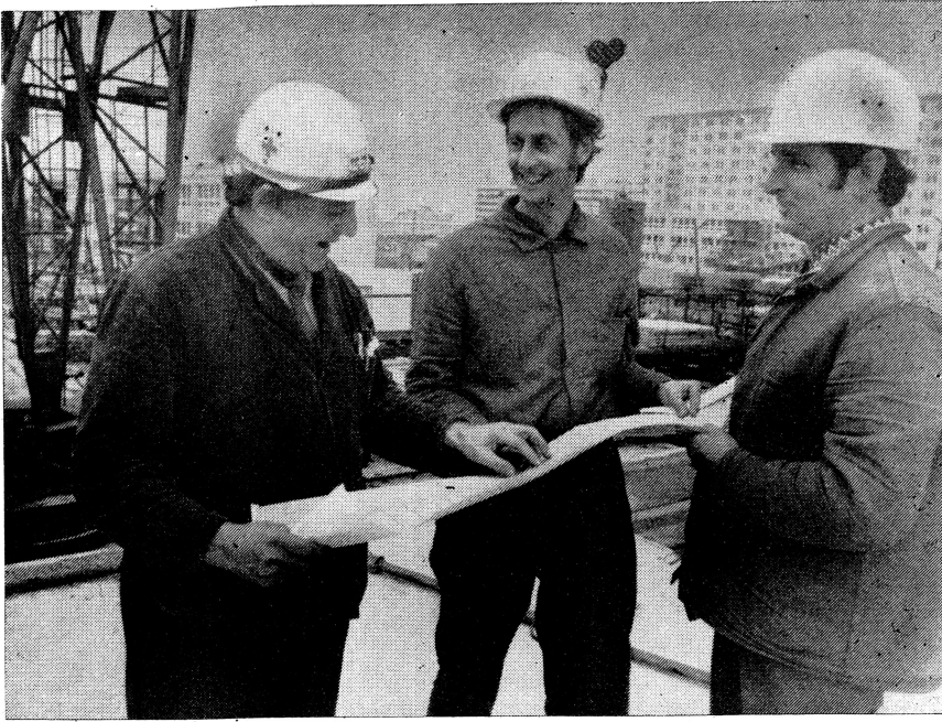
Meister Heinz Ritter, Montagebrigadier Peter Zeise und der stellvertretende Brigadier Gerhard Voigt bei einer Arbeitsberatung auf der Baustelle Berlin-Marzahn.
