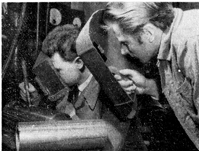
Der Schweißer Kollege Milde (rechts) aus dem VEB Chemische Fabrik Finowtal erhielt beim ZIS Halle vom Kollegen Kr e β m a n n Anleitung im Schweißen eines Spaltröhres
